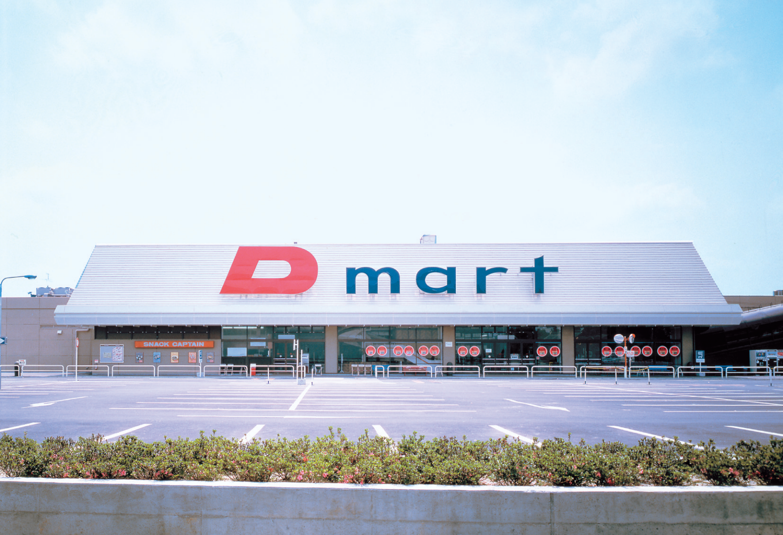
Dマート（千葉県）／工法：ハーバースルーフ225
