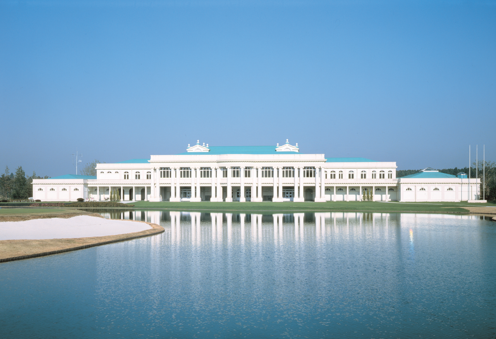
ミルフィーユ ゴルフクラブ (千葉県) / 工法: ハーバースブルーフ225
