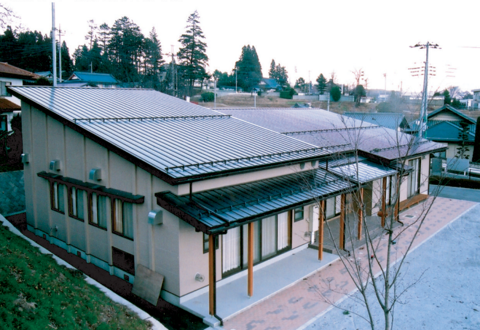
小淵沢ふれあいセンター（長野県）／工法：ハーバースルーフ大和葺Y165
